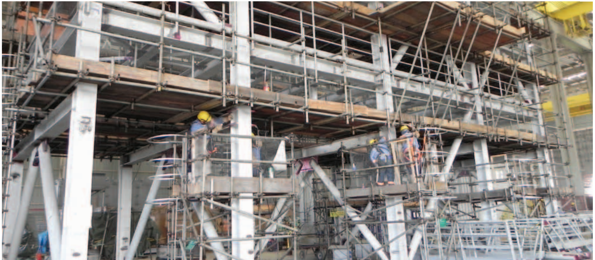
Montagem do Pipe Rack | Plataforma P-55 QUIP SA | Rio Grande – RS
